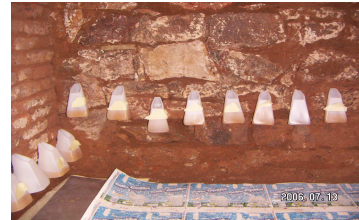
Bild zeigt die Trichtertränkung einer befallenen Wand
